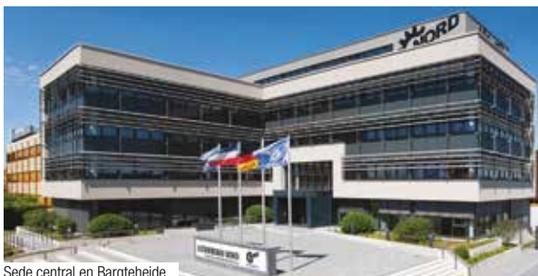
Sede central en Bargteheide
