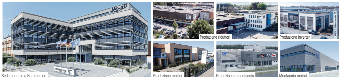
Sede centrale a Bargtheide
