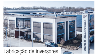
Fabricação de inversores
