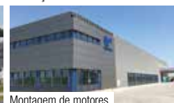
Montagem de motores
