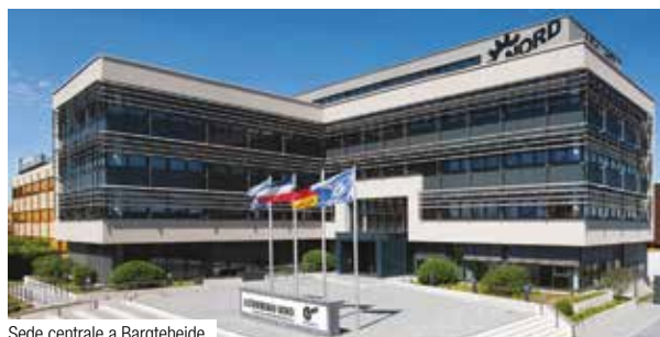
Sede centrale a Bargteheide
